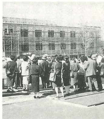
建設現場 視察
