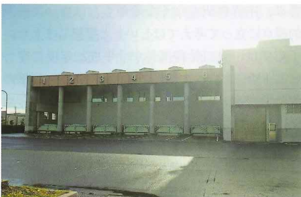
八重田浄化センターの積雪・融雪処理槽。排雪された雪を溶かし、土砂などを取り除いて放流する
