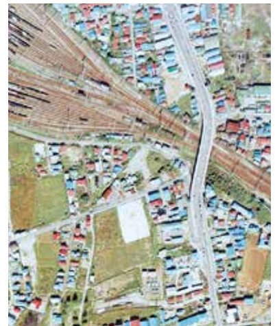
八甲田大橋周辺(昭和50年撮影、 国土地理院の空中写真)
